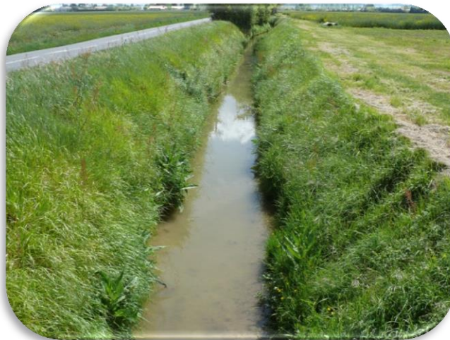
Fig. 14. Le Hautmont en limite Sud-Est de Saubens (photo ARTELIA)
