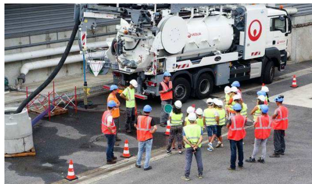
Explications sur une intervention sur le réseau
